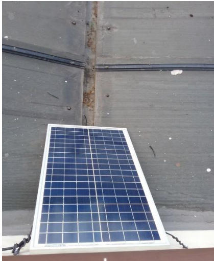
Gambar 1. Penempatan panel surya di atap kanopi Lantai dua SMP N 264 Jakarta Barat
