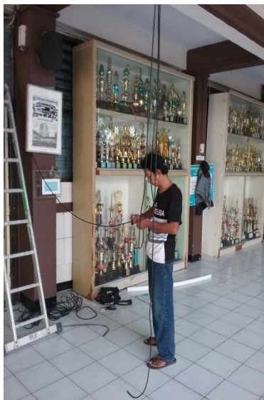
Gambar 3. Instalasi pemasangan kabel panel surya di SMPN 264 Jakarta Barat.
